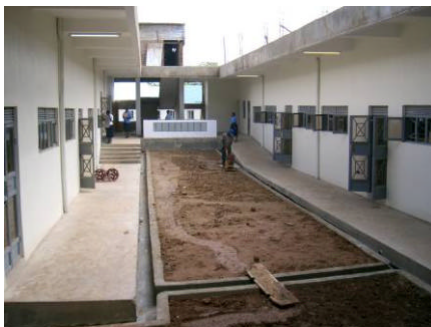
De binnenplaats van het grote schoolgebouw
